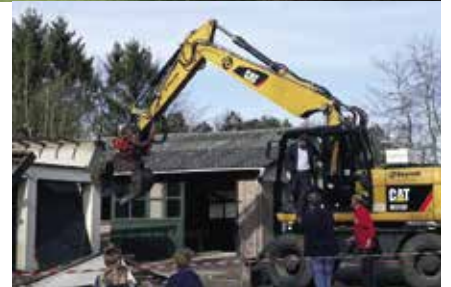
afbraak garage en werkplaats
